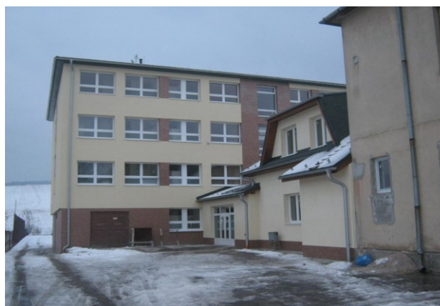
Obrázok č. 11 Zrekonštruovaný nový pavilón ZŠ a vytvorený spojovací křčok medzi dvoma budovami ZŠ
